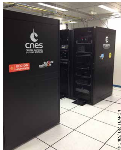
Salle des baies, CESARS.
